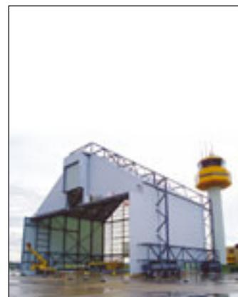
Rückzuck eine Halle auf Räder gestellt hat der Ulmer Fahrzeugbauer Kamag Transporttechnik. Dadurch wird diese Zusatzhalle mobil und kann als Verlängerung vorhandener Hangars dienen, um Flugzeuge mit größerer Länge unter Dach warten zu können.
