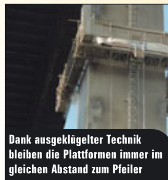
Die Verankerungen konnten alle außerhalb der Sanierungsfelder platziert werden
