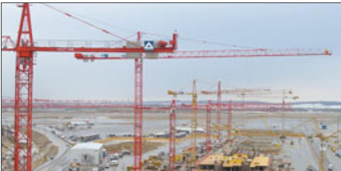
Gleich elf Wolff-Krane aus der Mietflotte des Heilbronner Herstellers sind beim Bau des dritten Terminals auf dem Flughafen Wien-Schwechat im Einsatz. Vier Kompakte vom Typ 6028.12, zwei Wolff 71 SL, zwei Wolff 6522 FL-6/12, zwei Wolff 7031 FL-6/12 sowie ein Wolff 7532.12, allesamt Obendreher mit Laufkatzausleger, haben sich unter anderem zum Rudel zusammengefunden. Das Auftragsvolumen wird auf 1,1 Millionen Euro beziffert. Auch
