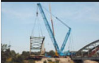
vor Ort war. Für die Schwerhübe zeichneten Felbermayr und Riga/Baumann verantwortlich. Zwei Liebherr-Krane vom Typ LR 1750 mit Raupenfahrwerken kamen zum Einsatz, wobei die Maschine von Riga/Baumann 1,5 Meter breite Ketten und das Felbermayr-Modell zwei Meter breite Ketten aufwies. Beide Krane konnten eine Gesamthublast von 256 beziehungsweise 260 Tonnen stemmen. Auf 42 Lastwagen verteilt, waren die Krane in den Tagen zuvor an den Einsatzort transportiert worden.
