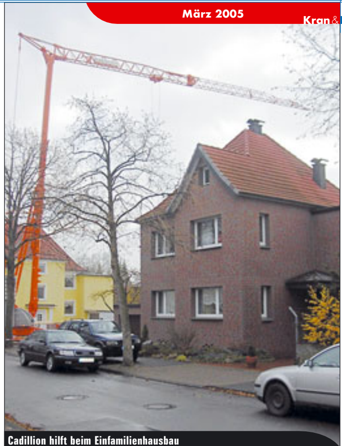
Cadillion hilft beim Einfamilienhausbau
