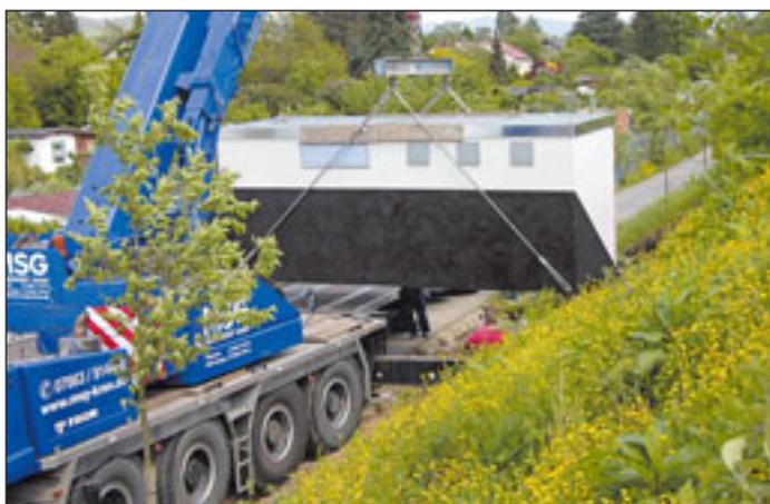
Erstmals wurde eine Solaranlage auf das Dach eines Straßentunnels aufgesetzt. Um auch die je 18 beziehungsweise zwölf Tonnen schweren Trafos auf den Fahrbahndeckel der B31 Ost durch Freiburg platzieren zu können, musste eigens ein Tadano Faun ATF 70-4 von MSG anrücken, um die beiden Einheiten von der acht Meter entfernten Straße, die durch ein Kleingärtnerviertel führt, einzuheben.
