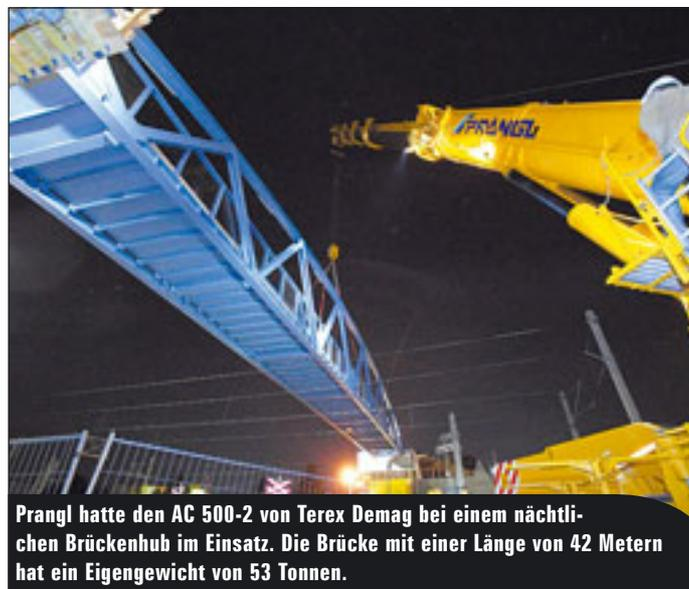
Prangl hatte den AC 500-2 von Terex Demag bei einem nächtlichen Brückenhub im Einsatz. Die Brücke mit einer Länge von 42 Metern hat ein Eigengewicht von 53 Tonnen.
