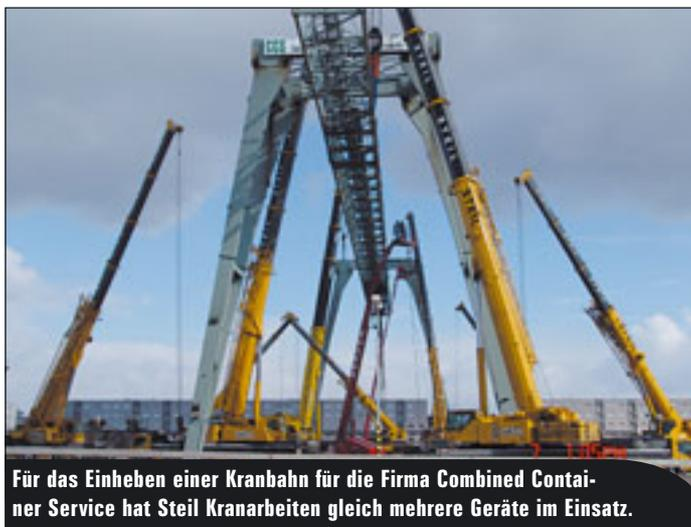
Für das Einheben einer Kranbahn für die Firma Combined Container Service hat Steil Kranarbeiten gleich mehrere Geräte im Einsatz.
