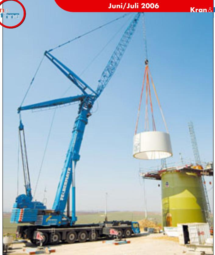
Der Liebherr LG 1750 wurde im April an Felbermayr ausgeliefert und kam gleich zum Einsatz beim Aufbau einer Windkraftanlage.
