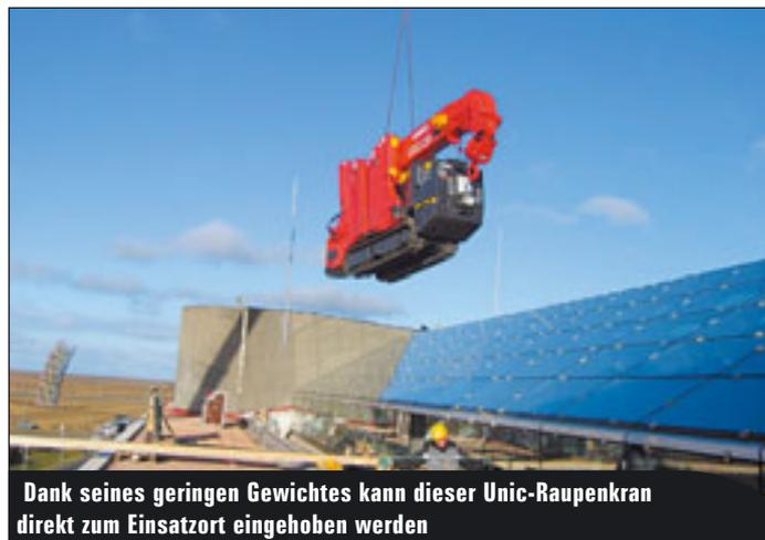
Dank seines geringen Gewichtes kann dieser Unic-Raupenkrane direkt zum Einsatzort eingehoben werden
