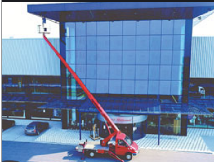
Fassadenarbeiten mit der Ruthmann TB 220
