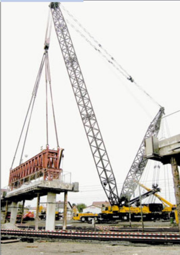
Im Zuge des Ausbaus der Bahnstrecke München-Augsburg von vier Gleisen auf sechs Gleise musste die Eisenbahnüberführung der alten Staatsstraße St 2345 von Gernlinden nach Maisach nahe dem bayrischen Fürstfeldbruck durch ein neues Brückenbauwerk ersetzt und das vorhandene Bauwerk abgebrochen werden.
