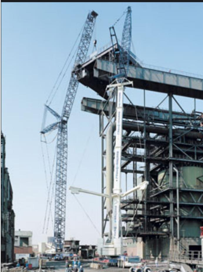
**Große Ausladungen mit vor allem hohen Traglasten zeichnen die Großkrane aus. Zum Einheben von Lüftungsteilen in einer industriellen Fertigungshalle in Bretten nahe Karlsruhe setzte Wiesbauer seinen Terex-Demag AC 700 ein. Ausgestattet mit 76 Meter Wippausleger erreichte der Kran die notwendige Ausladung von 94 Metern um die rund zehn Tonnen schwere Last an ihren neuen Standort zu heben.**
