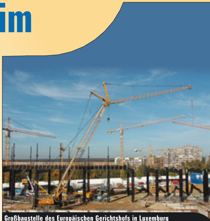
Großbaustelle des Europäischen Gerichtshofs in Luxemburg
