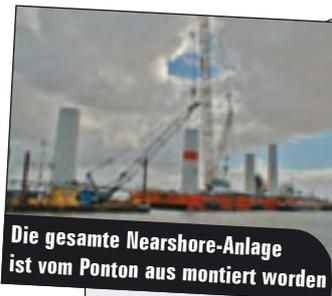
Die gesamte Nearshore-Anlage ist vom Ponton aus montiert worden
