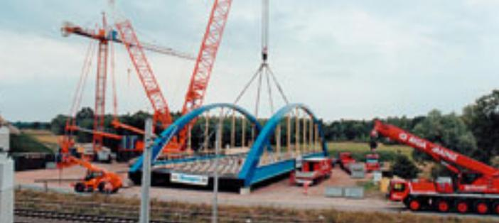
Trotz zeitgleich laufender Olympiaübertragungen wollten viele Zuschauer lieber das Spektakel einer Brückeneinhebung bei Stendal verfolgen. In nur knapp einer Stunde wurde die rund 340 Tonnen schwere Stahlbrücke mit einem Gittermastraupenkrane (Liebherr LRD 1750) aufgenommen, verfahren und über der ICE-Strecke in die Endlage gehoben.
