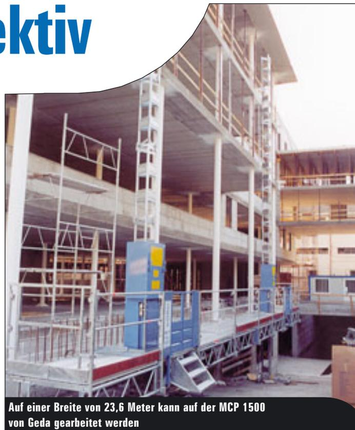
**Auf einer Breite von 23,6 Meter kann auf der MCP 1500 von Geda gearbeitet werden**
