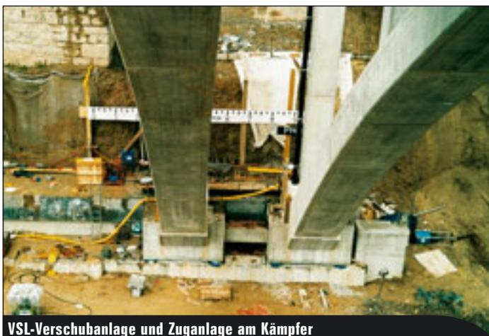
VSL-Verschubanlage und Zugsanlage am Kämpfer
