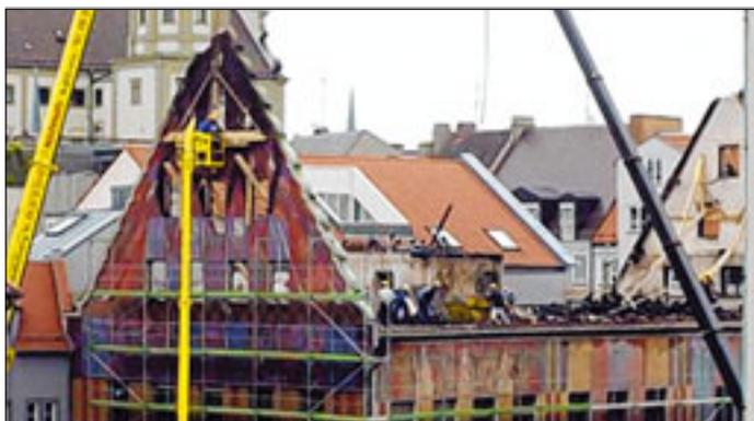
Wieder in alter Pracht strahlt das Weberhaus in Augsburg. Dank dem Einsatz eines Compact Truck Kran und mehreren Arbeitsbühnen ist es wieder originaltreu hergerichtet worden. System Lift begann gemeinsam mit dem Partner Hochmuth aus Augsburg sofort nach den Löscharbeiten mit dem Entfernen der absturzgefährdeten Dachteile. Wegen der Einsturzgefahr mussten die Arbeiten nicht nur sicher, sondern auch besonders schnell gehen. Mehr unter [www.Vertikal.net](http://www.Vertikal.net)
