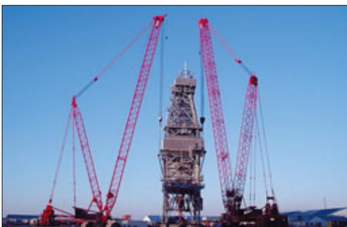
Zwei Manitowoc Model 18000 beim Umsetzen des Turmes einer Ölplattform in Baku, der Hauptstadt von Aserbaidschan. Die Last bringt stolze 400 Tonnen auf die Waage, hat eine Höhe von 50 Metern und einen Durchmesser von 20 Metern.
