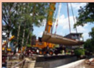
Eine neue Straßenbrücke über den Zellweger-Kanal im schweizerischen Uster hat Toggenburger unlängst eingehoben. Die vorgefertigte Betonbrücke mit einer Länge von 28 Metern und einem Eigengewicht von 140 Tonnen galt es dabei präzise in die vorbereiteten Widerlager einzupassen. Zum Einsatz kam der Demag AC 500-1
