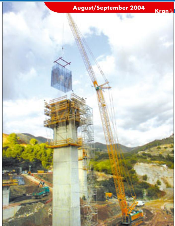
Das jüngste Mitglied aus der Reihe der Gittermastraupenkrane von Sennebogen, der Starlifter 3300 der Firma Guas Alhambra, beim Bau eines Brückenpfeilers in Spanien
