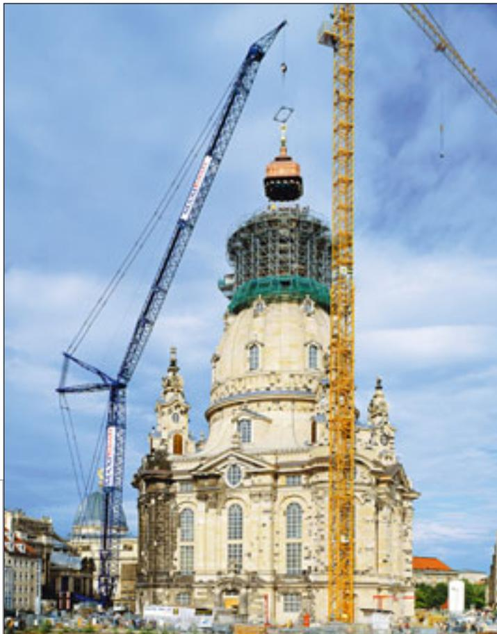
Stahlseilen hängend in 80 Metern Höhe und bei einer Ausladung von 39 Metern auf die steinerne Kuppel gesetzt werden musste.
