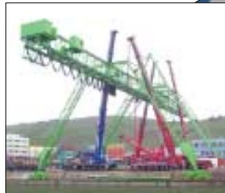
Beim Einhub eines insgesamt 270 Tonnen schweren Portalkrans im Stuttgarter Hafen packten zwei 450-Tonner und zwei 160-Tonner an den Stahlträgern zu. Unterstützung erhielten die Geräte von einem 70-Tonner und einem weiteren 160-Tonner.
