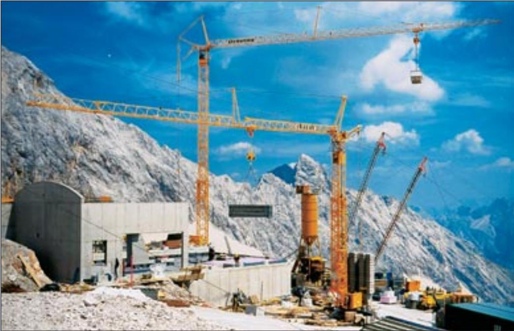
Für den Bau der neuen Sonnenkarbahn auf dem Zugspitzplatt wurden die beiden Liebherrkrane des Typs 42 K und 56 K komplett zer-
