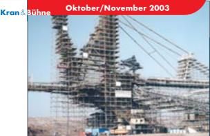
50.000 Kubikmeter Gerüst umspannen den 60 Meter hohen und 250 Meter langen Absetzer im Tagebau Profen
