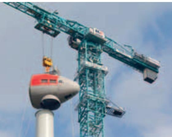
Flat-Top-Kran das Flaggschiff bei Liebherr Turmdrehkränen. Der Kran errichtete eine Enercon-Windkraftanlage E-101 mit 135 Metern Nabenhöhe und erreicht die nötige Hubhöhe von 149 Metern mit nur einer Abspannung am Turm der Anlage. Der Flächen-
