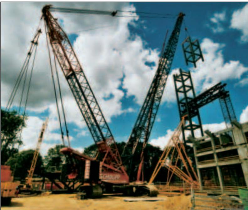
Für den Neubau des Müngersdorfer Fußballstadion in Köln kommt der Demag CC 2500 von Scholpp zum Einsatz. Der Raupenkran hebt hier eine Stahlkonstruktion mit 62 Tonnen Gewicht bei einer Ausladung von 50 Metern und 70 Metern Höhe ein. Das Gerät war mit einem 96 Meter langem Hauptmast ausgerüstet, der Superballast betrug 160 Tonnen.
