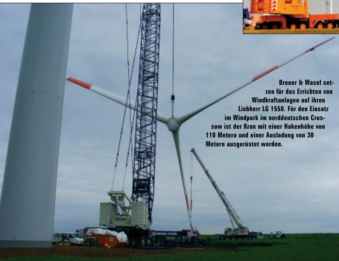
**Breuer & Wasel setzen für das Errichten von Windkraftanlagen auf ihren Liebherr LG 1550. Für den Einsatz im Windpark im norddeutschen Crussow ist der Kran mit einer Hakenhöhe von 110 Metern und einer Ausladung von 30 Metern ausgerüstet worden.**
