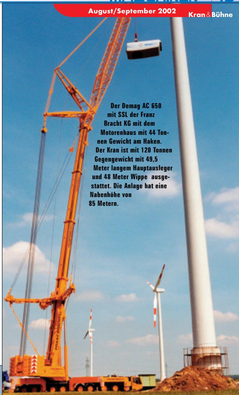
**Der Demag AC 650 mit SSL der Franz Bracht KG mit dem Motorenhaus mit 44 Tonnen Gewicht am Haken. Der Kran ist mit 120 Tonnen Gegengewicht mit 49,5 Meter langem Hauptausleger und 48 Meter Wippe ausgestattet. Die Anlage hat eine Nabenhöhe von 85 Metern.**
