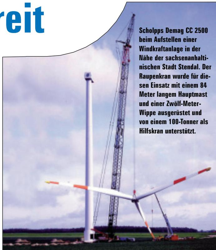
Die heutigen Anlagen bis rund 100 Meter sind sowohl von großen Raupenkränen als auch sehr großen Mobilkränen auf AT-Fahrgestell aufstellbar. Die Vorteile des Raupenkrans liegen zweifelsohne in den besseren Traglastwerten. Darüber hinaus kann das Gerät voll ausgerüstet von einem Standort zum nächsten innerhalb eines Windparks verfahren werden. Der AT muss hierzu stets ab- und aufgebaut werden. Was die Raupe innerhalb von 30 bis 60 Minuten schafft, braucht mit dem AT um die 24 Stunden.
