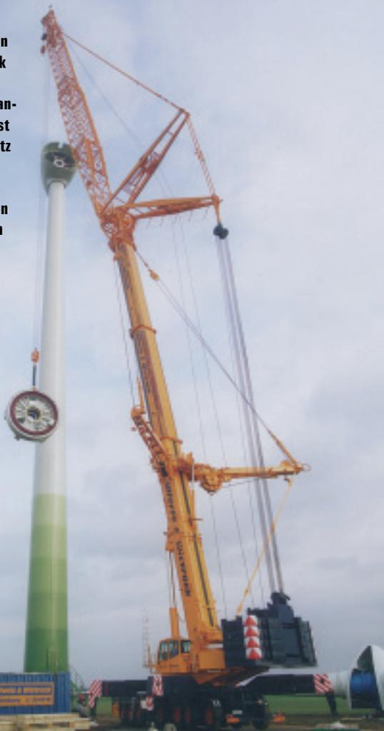
**Scholpps Demag CC 2500 beim Aufstellen einer Windkraftanlage in der Nähe der sachsenanhaltinischen Stadt Stendal. Der Raupenkran wurde für diesen Einsatz mit einem 84 Meter langem Hauptmast und einer Zwölf-Meter-Wippe ausgerüstet und von einem 100-Tonner als Hilfskran unterstützt.**
