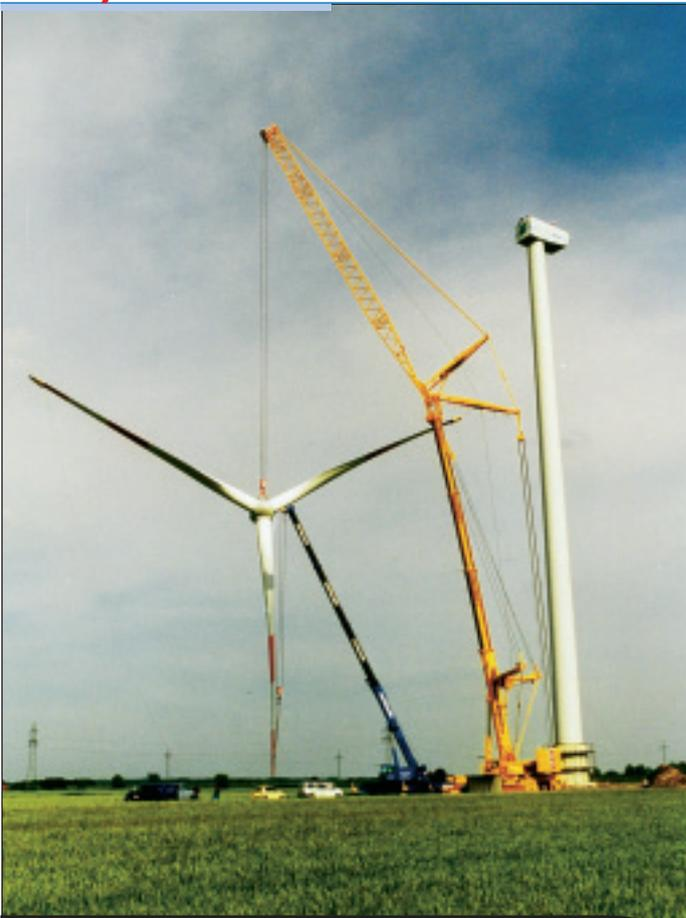
Das Aufstellen von Windkraftanlagen ist bei dem Unternehmen Franz Bracht ein großes Standbein für die Großgeräte. Das Bild zeigt den Demag AC 650 bei der Errichtung einer Anlage mit 85 Meter Nabenhöhe und 77 Meter Rotordurchmesser. Für die Turmschüsse mit 52 Tonnen, die Gondel mit 44 Tonnen und den Rotor wurde der AC 650 mit 49,5 Meter langem Hauptausleger, 48 Meter Wippe und SSL ausgestattet. Als Gegengewicht wurden 120 Tonnen angebracht. Als Hilfskran kam ein LTM 1090 zum Einsatz.
