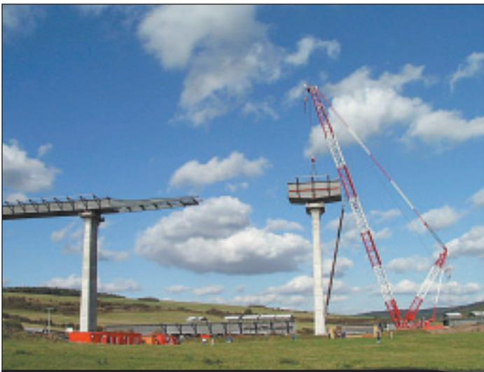
Für die Neubauarbeiten an der ein Kilometer langen Reichenbachbrücke, einem Teilabschnitt der A 71 von Erfurt nach Schweinfurt, setzte der Demag CC 2800 von PKT die rund 250 Tonnen schweren Stützen auf die mittleren Pfeiler. Der Abstand zwischen Fahrbahn und Talgrund beträgt an der tiefsten Stelle 59 Meter.
