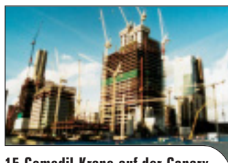
15 Comedil-Krane auf der Canary Wharf, davon sieben CTL400 Wippauslegerkrane
