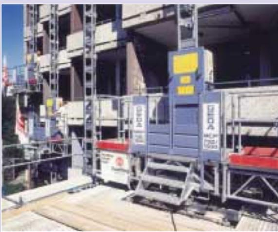
Bei der Renovierung des 65 Meter hohen Europahauses in Aachen setzte die ausführende Firma Gerüstbau Triller auf Mastkletterbühnen. Sämtliche Arbeiten mussten von außen erbracht werden, weshalb Triller sich in Kooperation mit Baumaschinen Deubner aus Aachen für vier MCP 750 von Geda entschieden hat. Die Außenarbeiten wurden innerhalb von 16 Wochen durchgeführt.
