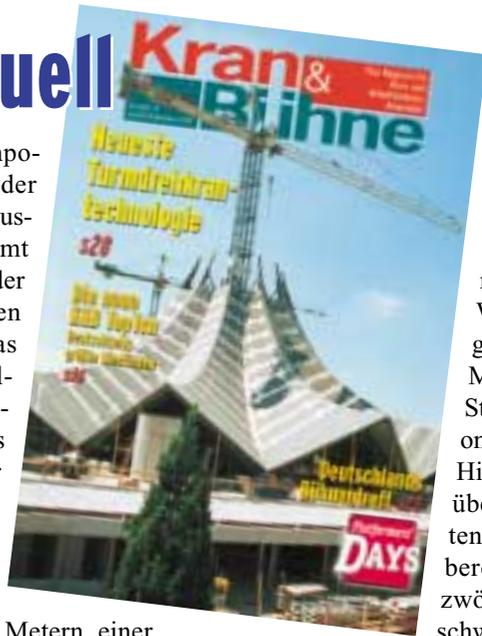
ausgerüstet und inmitten des geplanten Gebäudes errichtet worden. Wichtigste Aufgabe war die Montage der Stahlkonstruktion des Daches. Hierfür waren über den gesamten Ausladungsbereich bis zu zwölf Tonnen schwere Stahlkonstruktionsteile zu heben und genau an der vorgesehenen Stelle zu platzieren.
