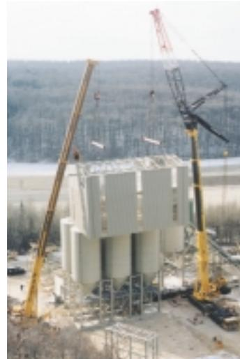
Nachdem das Maschinenhaus mittels Spezialtraversen und Gehänge angeschlagen war, wurde es von den beiden Kranen bei einer Ausladung von 15 Meter hochgehoben, eingeschwenkt und abgesetzt. Nach vier Stunden war der Auftrag erledigt.
