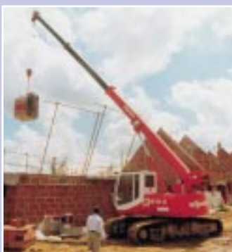
Beim Bauunternehmen Comet in Paris sind sieben 613 R-Raupenkrane mit 18,8-Meter-Telesausleger im Einsatz.
