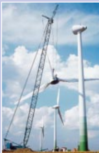
Einmal aufgerüstet fährt der Demag CC 2800 innerhalb des Windparks in wenigen Stunden von einer Aufstellposition zur nächsten.
