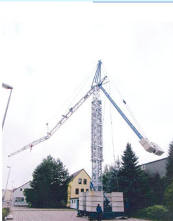
KSD KK4512: 45 Meter Ausleger und 12 Meter Gegenausleger inklusive Gegengewicht werden in die Hakenhöhe von 20 Meter gebracht
