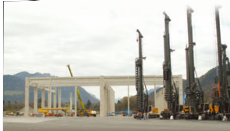
Schon im Bau, die neue Halle in Nenzing
