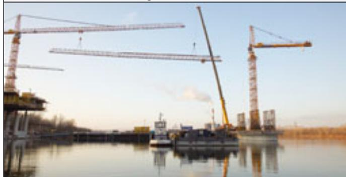
Da das Ponton aufgrund der Donautiefe nicht abstützbar ist, hat das Unternehmen Ballaststeine entsprechend platziert. So soll die Pontonbewegung beim Verheben der Kranteile so gering wie möglich gehalten werden. Zuvor wurde das Ponton mit einer Eisentraverse am Brü-
