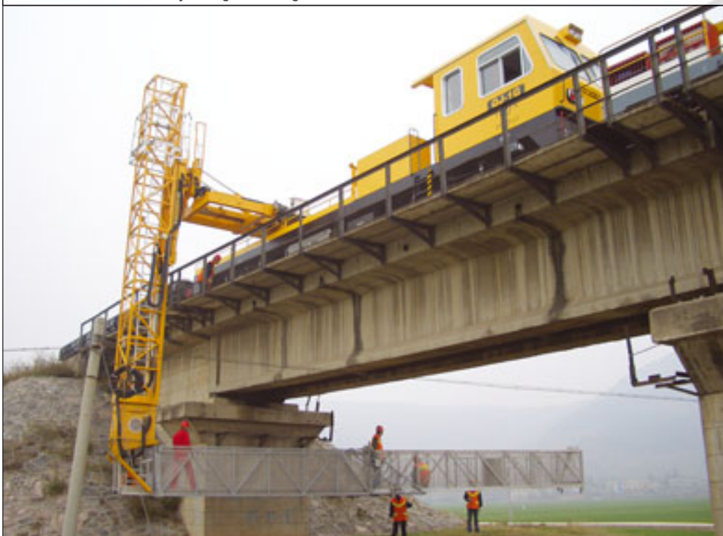
Zwei MBS Geräten von Moog im Einsatz an der Wälz bachbrücke der Deutschen Bahn. Jedes Gerät beansprucht nur einen halben Meter im jeweiligen Gehwegsbereich.
