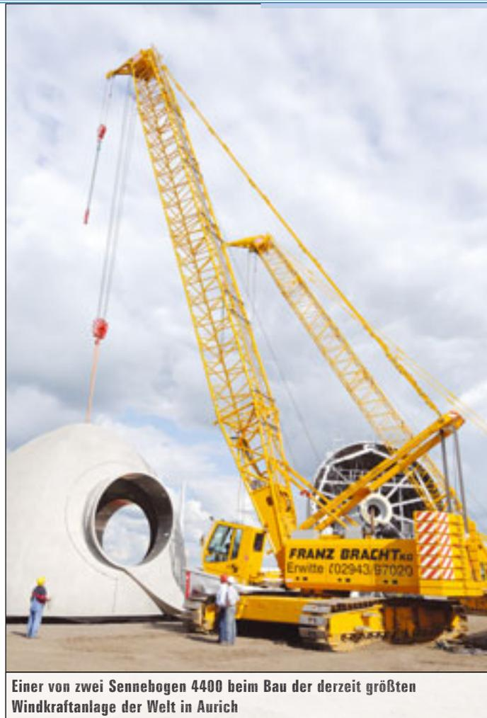
Einer von zwei Sennebogen 4400 beim Bau der derzeit größten Windkraftanlage der Welt in Aurich
