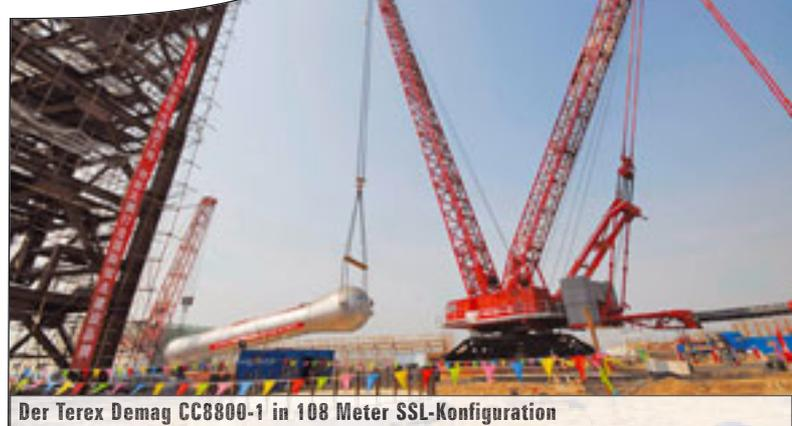
Der Terex Demag CC8800-1 in 108 Meter SSL-Konfiguration
