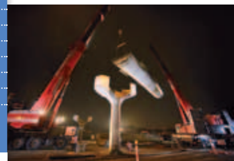
Scholpp-Krane demontieren den Wilhelmsteg in Stuttgart
