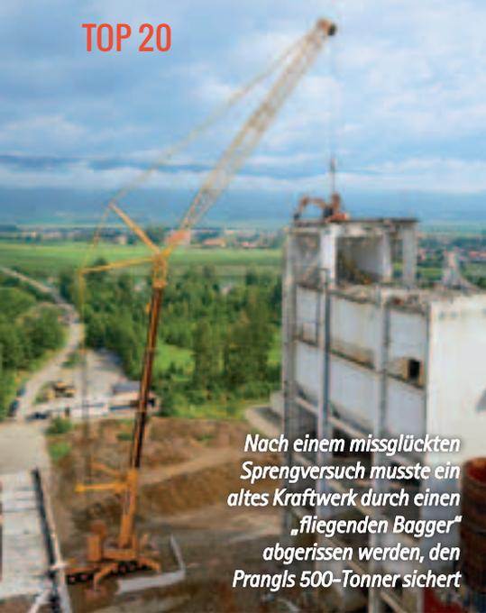
Nach einem missglückten Sprengversuch musste ein altes Kraftwerk durch einen „fliegenden Bagger“ abgerissen werden, den Prangls 500-Tonner sichert
