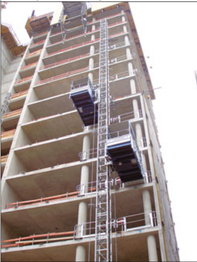
München, Skyline Tower: Böckers Superlift LX 2024 im Einsatz
