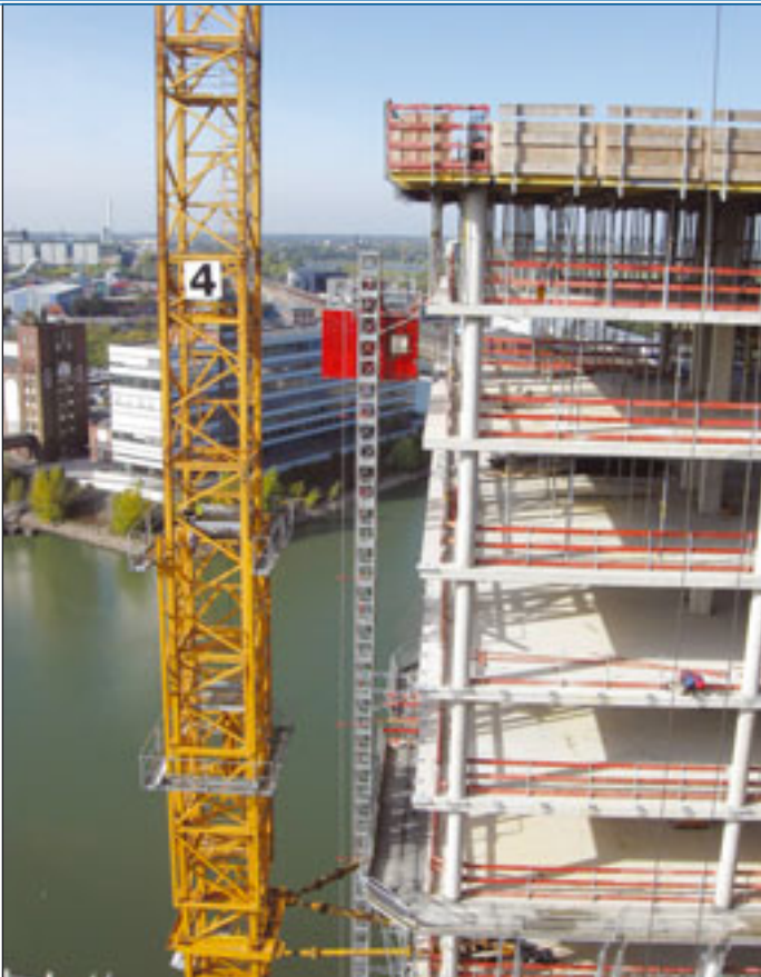
Düsseldorf, Hafenspitze: Erst in 21 Metern Höhe verankert ist der Scanclimber SC2032
