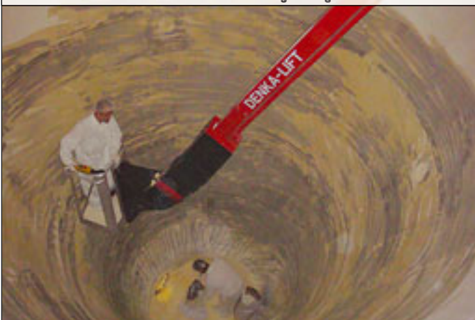
Mit der Bühne wird nun das Silo von innen gereinigt
