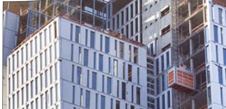
Frankfurt am Main, Palais Quartier: Alimak hat zwei Scando II 650 am Laufen
