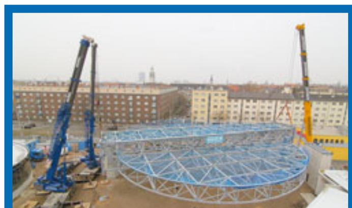
Drei Grove-Krane von Gräser positionieren in Mannheim eine 160 Tonnen schwere Dachkonstruktion auf einer Tankstelle.
