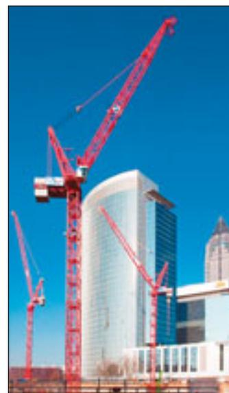
speziell für dieses Projekt ein Turmstück mit Sondermaß, um die Abspannungen optimal in die Zwischendecken des Gebäudes zu platzieren.
