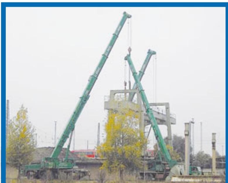
Die letzte freistehende Kranbrücke des traditionsreichen DDR-Maschinenbauers Saalfelder Hebezeugbau, 1967 errichtet, ist mit Hilfe von drei Mobilkränen demontiert worden. Dabei setzte Engel-Krane aus Burg auf die Faun-Modelle ATF 65 G4, ATF 110 G5 und ATF 160 G5.
