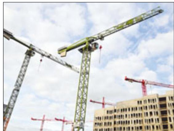
„Uns standen zwei Möglichkeiten zur Wahl. Wir konnten entweder einen größeren Kran verwenden, der sich weiter vom Projekt entfernt befand und über die Baustelle schwingen konnte. Oder wir konnten einen Topless-Kran mit einem kürzeren Hilfsausleger einsetzen, der unter dem bereits aufgebauten Kran schwingen würde. Wir haben uns für die zweite Möglichkeit entschieden,“ erläutert von Jens Höhns, geschäftsführender Gesellschafter und Ingenieur bei Höhns-Bau.
