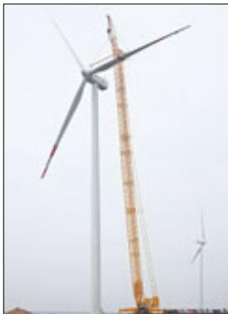
Ein 600-Tonnen-Schwerlastkran mit einem Raupenfahrwerk von nur 5,80 Meter Breite, das ist die Schmalspurversion des Liebherr LR 1600/2 mit dem Zusatz „W“ – wie Windkraft. Dieser neue Raupenkran stellte nun erstmals in der Praxis seine Fähigkeiten unter Beweis, und zwar im ungarischen Kisigmand, eine Autostunde westlich der Hauptstadt Budapest und unweit der Grenze zur Slowakei, beim Aufstellen von Windkraftanlagen mit einer Leistung von zwei Megawatt und einer Nabenhöhe von 100 Metern.
