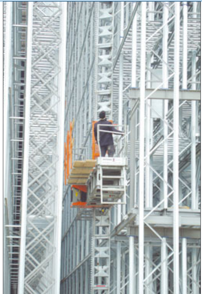
AST setzt eine FRSM 1500 von Fraco beim Hochregalneubau ein
