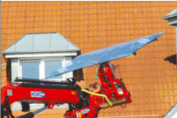
Das Anbringen von Glaselementen bis zu einer Tonne auch über Kopf ist mit dem SMK 320.67 möglich
