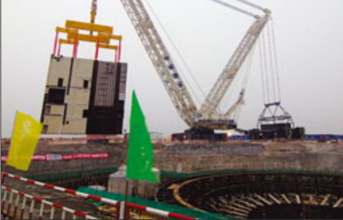
Kraftakt für den Terex CC8800-1 Twin: Zu Jahresbeginn wurde der Raupenkran vom Anlagenbauer Zongyuan Construction eingesetzt, um eine gigantische Generatoreinheit im Kraftwerk Haiyang in der chinesischen Provinz Shandong an ihren Platz zu heben. Der Einsatz umfasste den Hub des 20,96 x 14,17 x 20,96 Meter großen und 1.046 Tonnen schweren Generatormoduls und das Absetzen auf einem zehn Meter hohen Fundament. In der Konfiguration 69-Meter-Hauptausleger mit SSL
