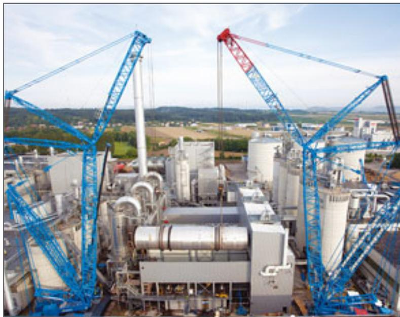
Felbermayr hat in Niederösterreich eine 305 Tonnen schwere Trockentrommel ausgetauscht. Der LR 1750 war mit insgesamt 452,5 Tonnen Ballast ausgestattet und der Hauptausleger mit einer 28 Meter hohen Wippe verlängert. Auch der LR 1600/2 brachte es auf stolze 365 Tonnen Ballast und war ebenfalls ergänzend zum Hauptausleger mit einer Wippe ausgestattet. Die Wippe war nötig, um die Last punktgenau auf den Transportfahrzeug (SPMT) ablegen zu können.
