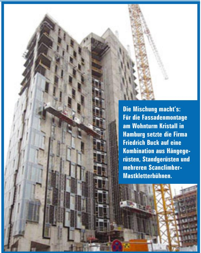
Die Mischung macht's: Für die Fassadenmontage am Wohnturm Kristall in Hamburg setzte die Firma Friedrich Buck auf eine Kombination aus Hängegerüsten, Standgerüsten und mehreren Scanclimber-Mastkletterbühnen.
