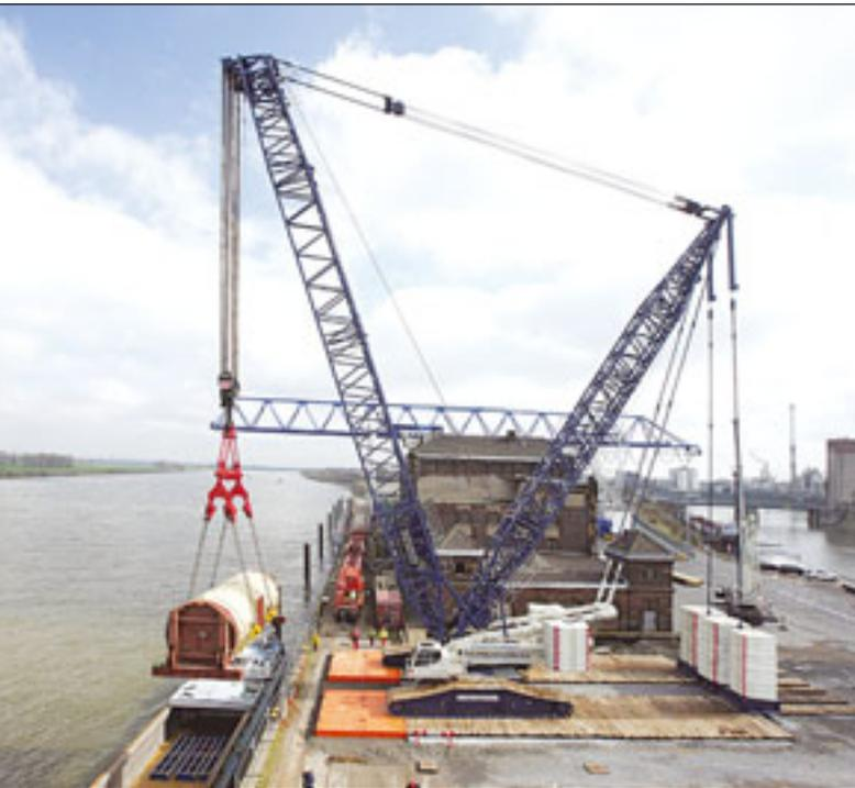
Schwergutumschlag im Hafen Krefeld: Für den Rücktransport eines Stators, dem Stahlgehäuse eines Stromgenerators, zum Herstellerwerk zogen die drei Schwerlastlogistiker Viktor Baumann, Riga Mainz und Breuer & Wasel an einem Strang. Die 454 Tonnen schweren Last wurde im Kraftwerk mit Litzenhubsystem ausgehoben und auf SPMT verladen, um zu einem Gleisanschluss transportiert zu werden. Der
