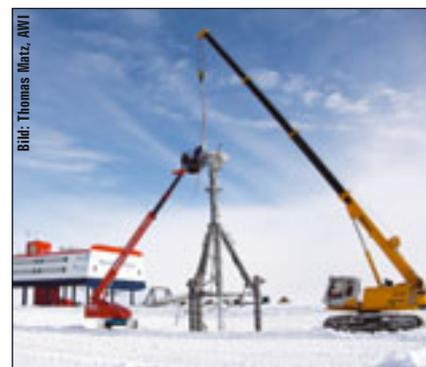
von den Schwerlastschlitten auf die Schneeoberfläche erst möglich geworden. Auch größere Gegenstände wie Antennenanlagen oder Messeinrichtungen können mit dem 643 R bis auf den Dachbereich der Station gehoben werden.
