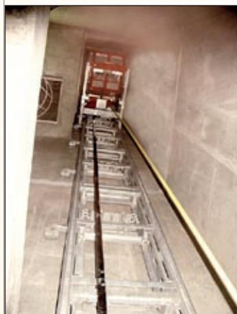
die Fahrbahnen des neuen City-Ringes befestigt. In den Pylonen geht es mit Aufzügen des Typs SC1000K von Scanclimber 56 Meter in die Höhe. Dabei ist eine leichte Bogenfahrt zu absolvieren. Um immer in der Waagerechten zu bleiben, ist der Aufzug mit Nivelliersystem ausgestattet.
