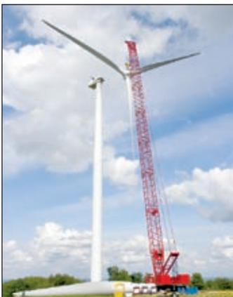
Das Windanbaugerät verleiht dem Modell 16000 von Manitowoc „Flügel“
