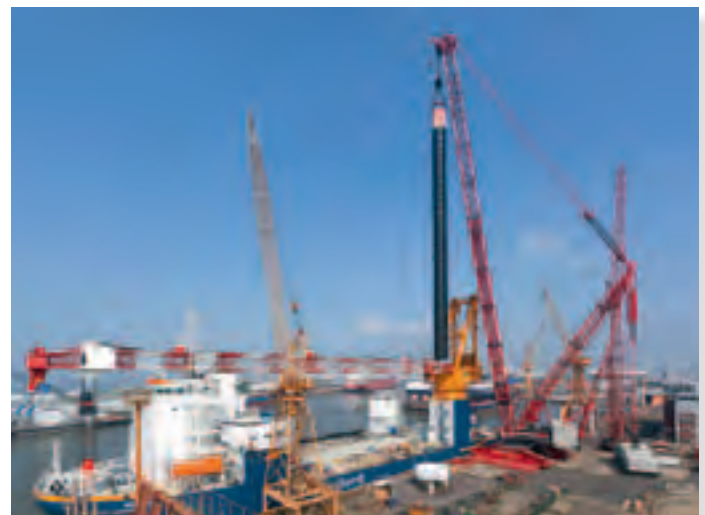
Mehr als 1.000 Tonnen Bruttolast hatte der LR 13000 von Mammoet am Haken
