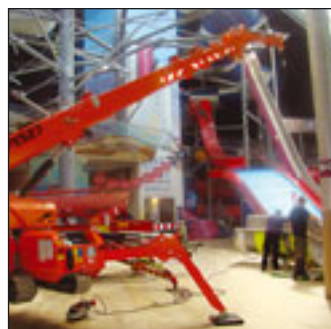
Die Punktbelastung pro Stütze liegt bei maximal 2.700 Kilogramm
