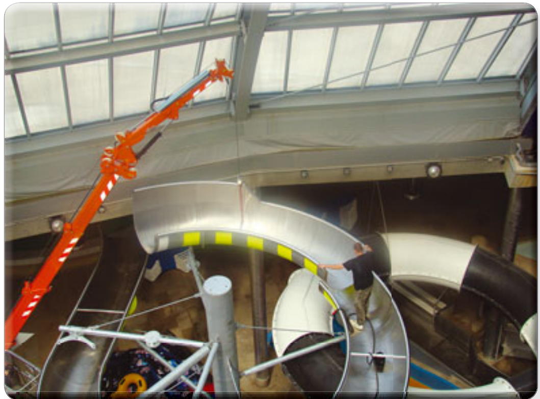
Das obere Profil kann durch das Knickstück seitlich bis zu vier Meter ausgefahren werden
