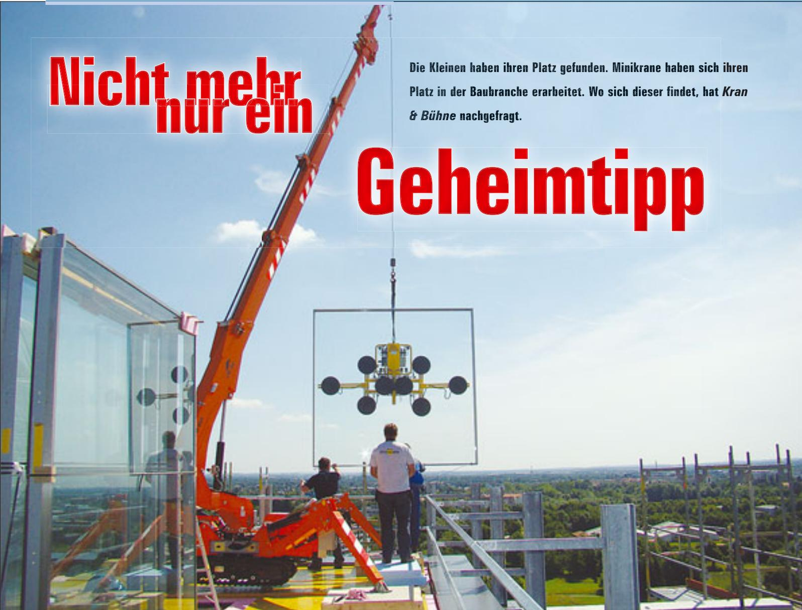
Dieser Jekko-Minikran hilft beim Bau eines Wintergartens in München – auf dem Dach eines Hochhauses im 40. Stockwerk
