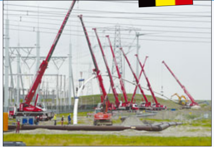
Acht Krane von Wagenborg Nedlift schultern die 400 Meter lange und 77 Tonnen schwere Pipeline
