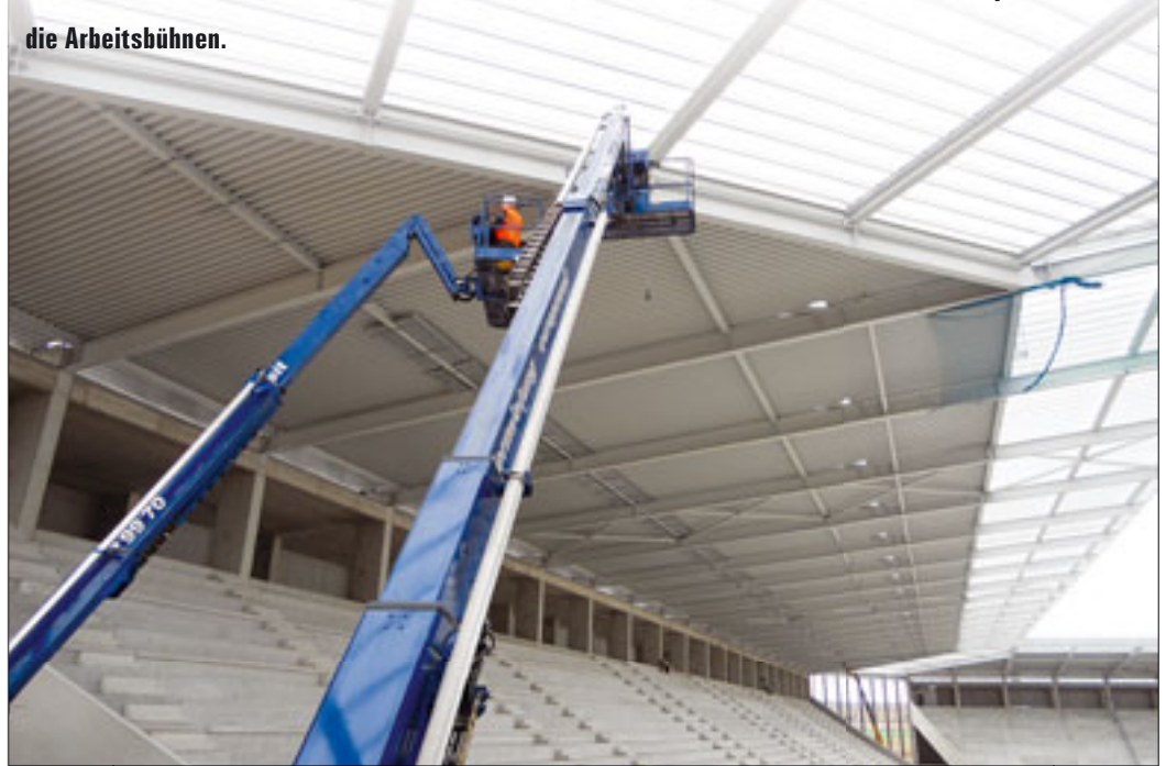
In der Fußballarena Mainz hat Beyer Mietservice zwei Diesel-Teleskopbühnen mit 34 und 40 Meter Arbeitshöhe bei Dacharbeiten eingesetzt
