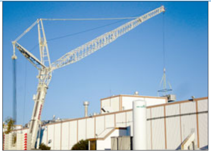
Der AC500/2 hebt Kühlkompressoren über heiklem Terrain ein
