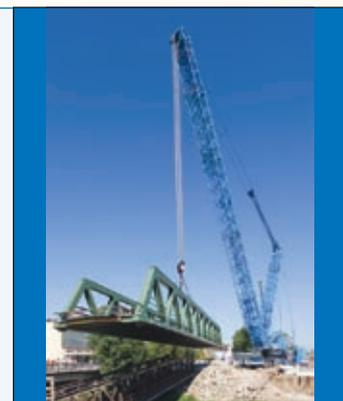
Beim weiteren Hub war es wichtig, mit zunehmender Ausladung der Last auch den Schwebeballast in entgegengesetzter Richtung auszufahren. Mittlerweile ist die Brücke schon längst für den Verkehr wieder freigegeben.
