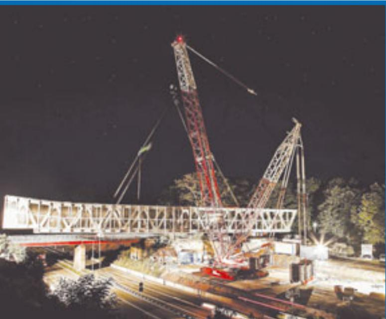
Der Krandienstleister **Riga aus Mainz** hat in einer Nachtaktion auf der A6 bei Kaiserslautern eine Fußgängerbrücke aus Stahl eingehoben. Im Zuge der Verbreiterung von vier auf sechs Spuren war dies nötig geworden. Dazu wurde die Autobahn 14 Stunden in beiden Fahrtrichtungen voll gesperrt. In diesem engen Zeitfenster musste Riga Mainz den Schwebeballast des Krans auf die Autobahn bringen, den Hub durchführen und die Autobahn wieder freigeben.
