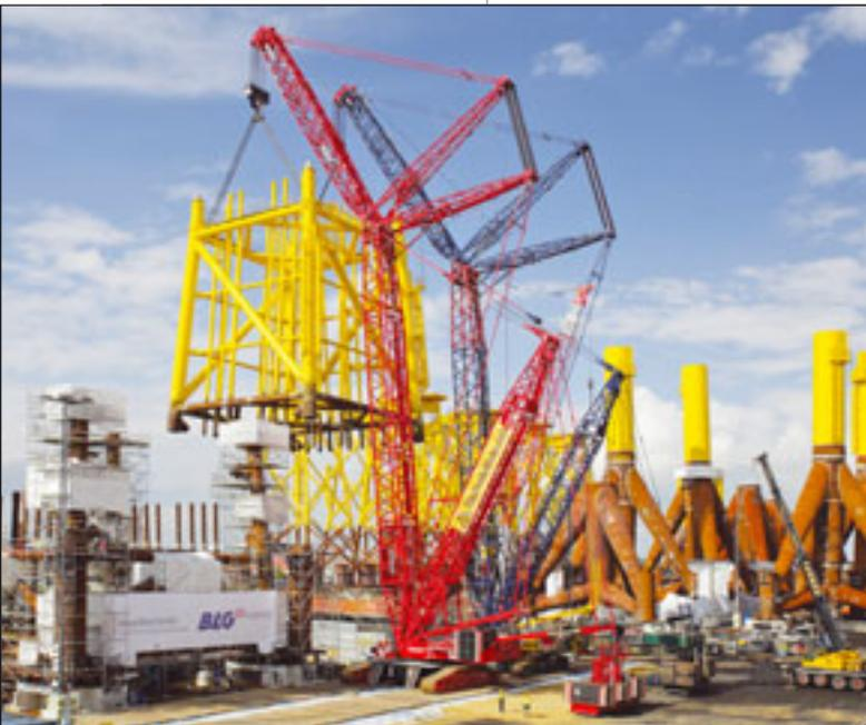
Auf dem BLG Offshore-Terminal ABC-Halbinsel in Bremerhaven wurde das Jacket, die Gründungsstruktur für die Umspannplattform des Offshore-Windparks „Borkum West II“, mit zwei 750-Tonnen-Raupenkränen
