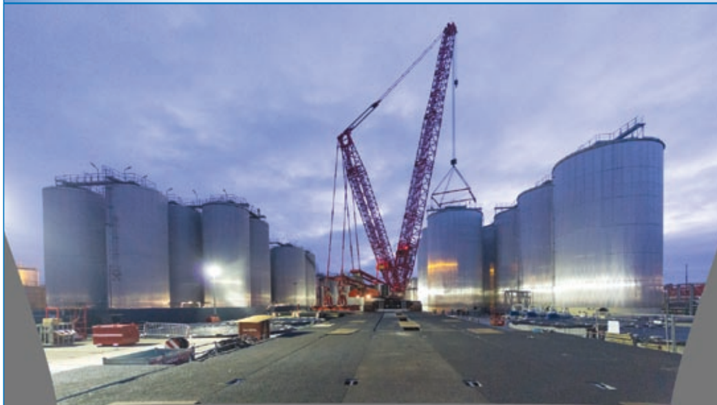
Ein LR 1750 setzt die Tanks nach einander an die jeweilige Endposition
