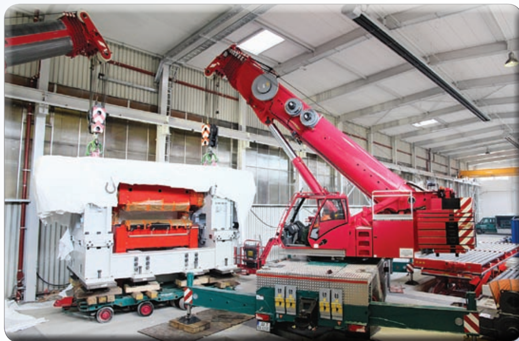
Feinfühlig positionieren die beiden „Indoor-Spezialisten“ eine Exzenter-Schwingschere
