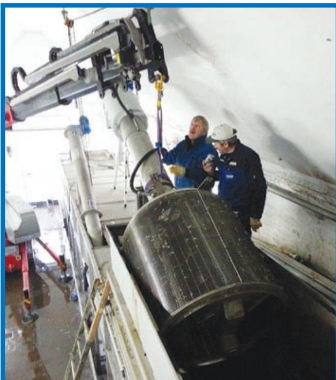
In Habichtswald muss die Kläranlage inklusive des 700 Kilogramm schweren Rechens regelmäßig gewartet werden. Die Eichenzeller Firma Wemo-Tec schickte dafür ihren Miniraupenkran SMK 190.4 in die Halle. Mit dem Knickpunkt des Kranarms bei vier Metern hat der Hub unterhalb der Hallendecke gerade so hingehauen.
